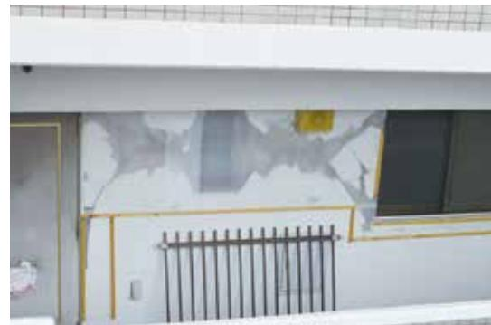
共用廊下の補修風景。サッシが取り外され、ひび割れの補修がはじまっていた。
