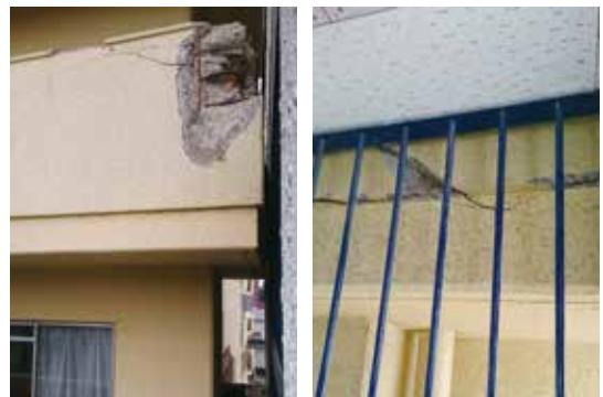
接触による破損したベランダ ベランダ下部より見るとひび割れがわかる
