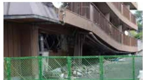
4月16日の本震によって倒壊。1階の柱が複数座屈していた。理事長曰く、座屈の程度が徐々に増しているとのこと。
